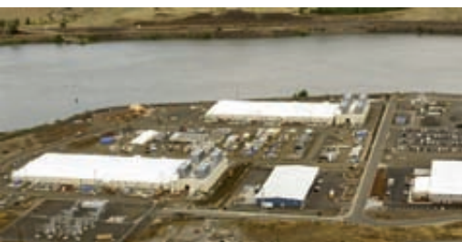
Google construeix dos centres de dades, a dalt a l'esquerra, cadascun de la mida d'un camp de futbol americà, a la localitat de The Dalles, Oregon.
